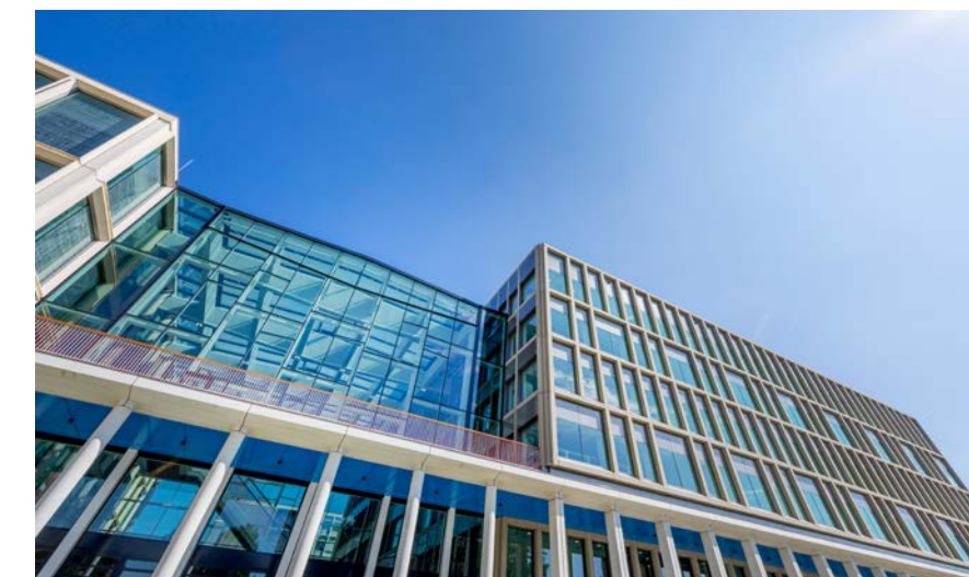
Op 1 oktober leverde de bouwcombinatie MedicomZes | Kuijpers het Research & Diagnostiek Centrum ADORE op.
